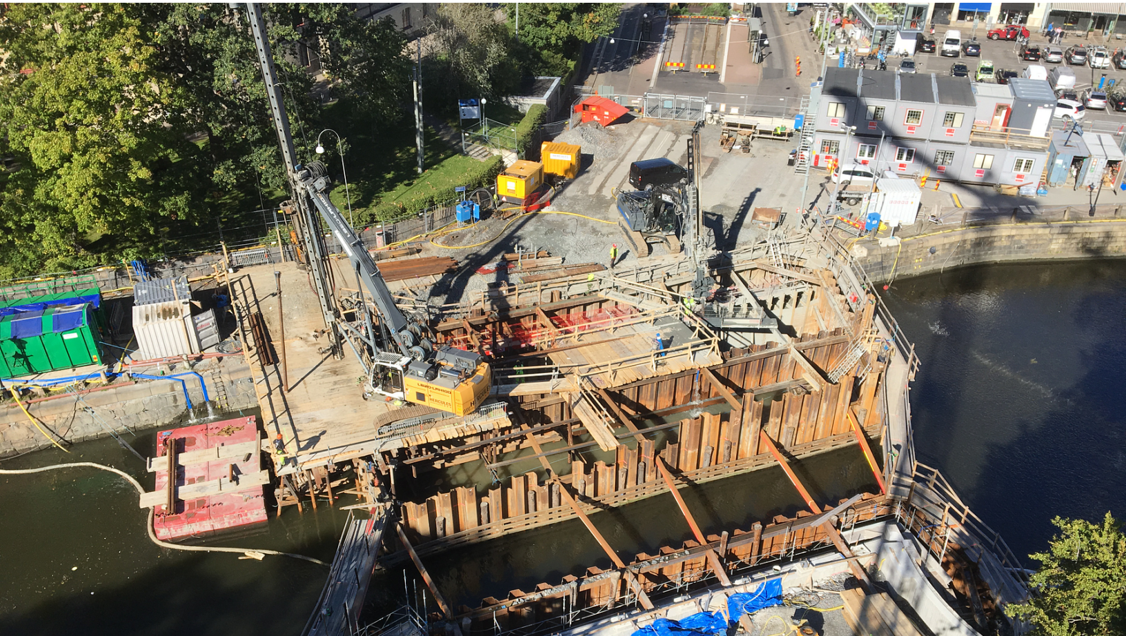
Den pågående rekonstruktionen av Vasabron över Vallgraven i centrala Göteborg. Bild: Trafikkontoret Göteborgs Stad
