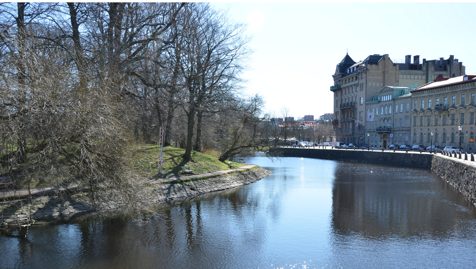
Kajkonstruktioner i centrala Göteborg
