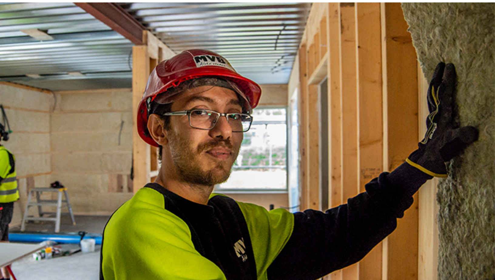
Goran Colic, sätter isolering på bygget i Frölunda
