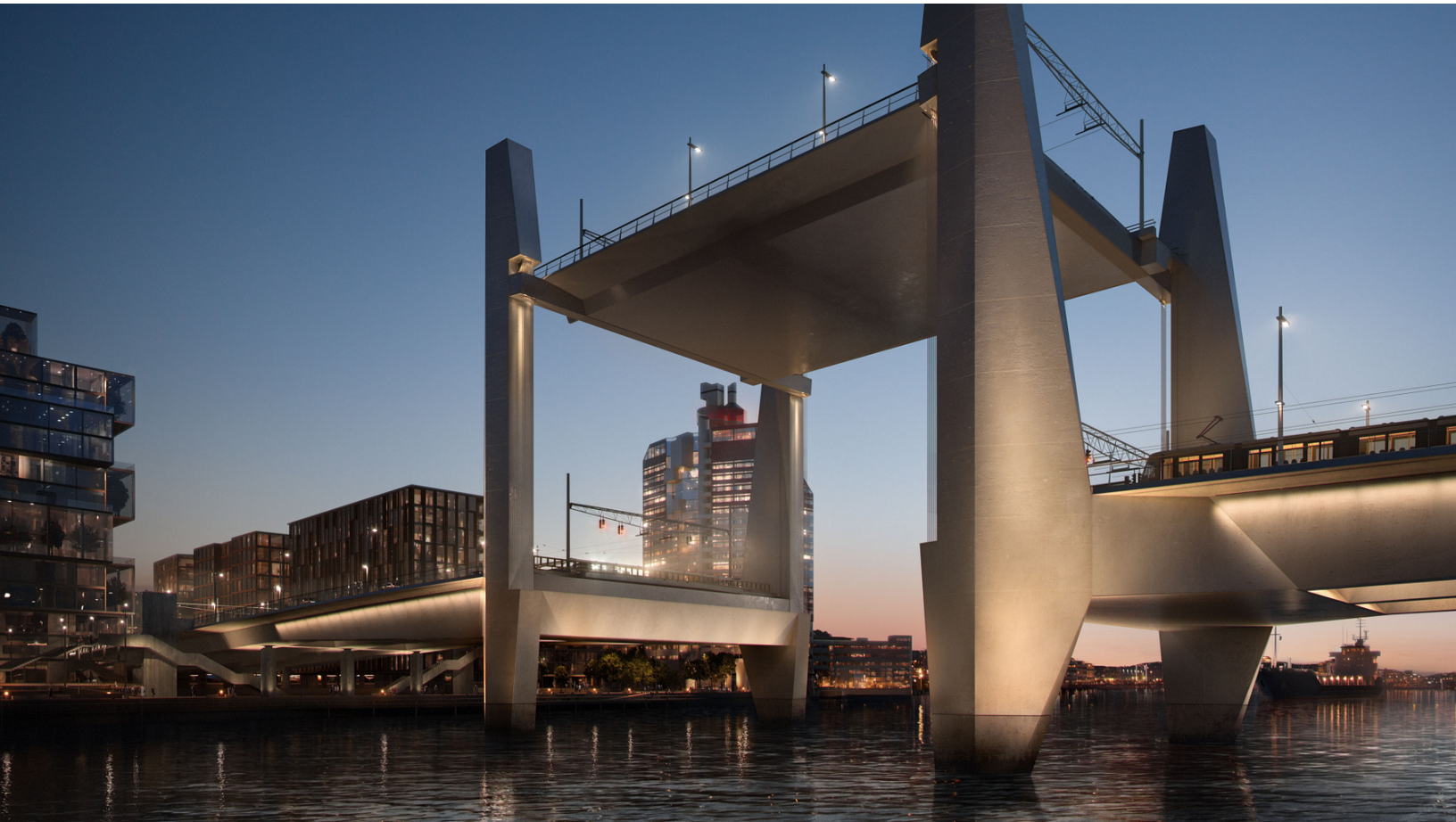
Hisingsbron blir med sina pyloner i stål ett nytt landmärke i Göteborg. Bild: Göteborgs Stad/Tomorrow
