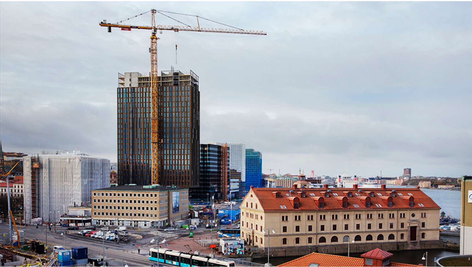
Byggarbetsplats runt Lagerhuset i Göteborg.
