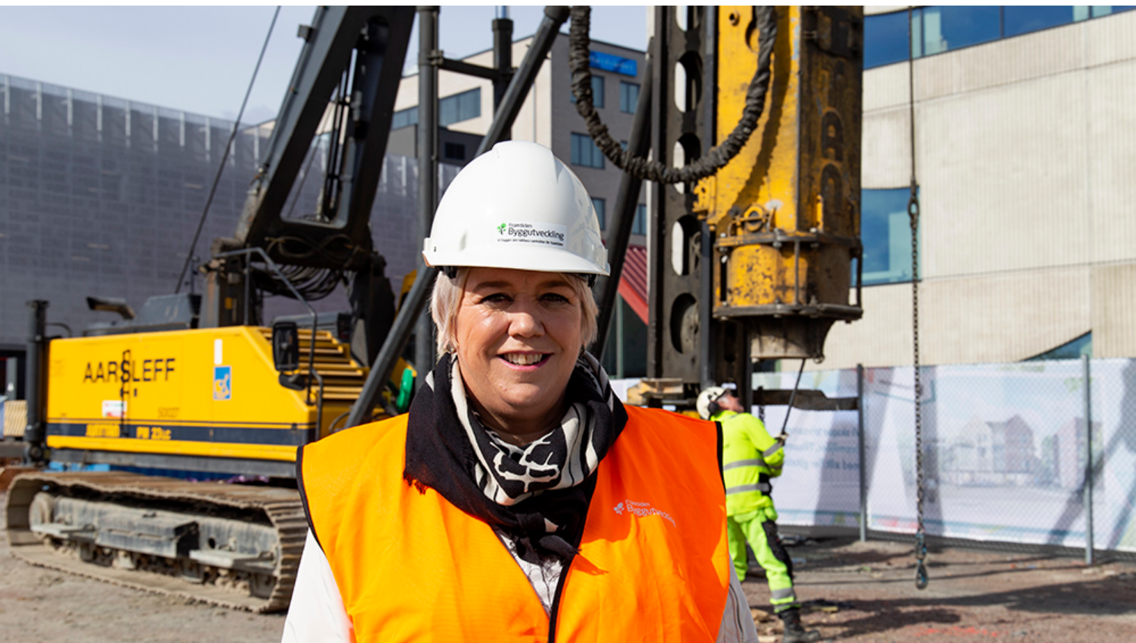
Margareta Larsson var på plats för att se det första påslaget inför bygget av nya Backahus äldreboende på Selma Lagerlöfs Torg Foto: Johan Twedberg
